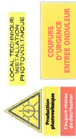
Figure 27 : Exemples de signalisation sur une installation photovoltaïque (source : www.edquec-photovoltaique.com)
